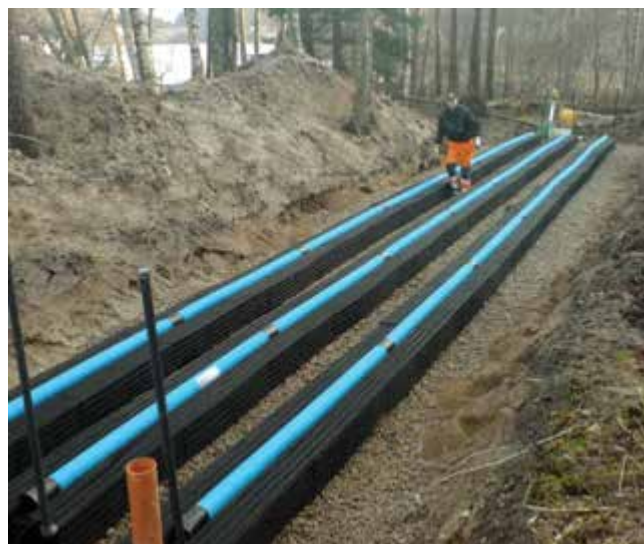
Infiltrasjonsgrøft med BioModuler.
