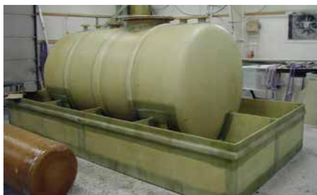
Kjemikalietank med sikkerhetskar.
