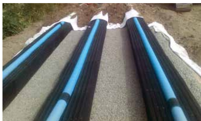
Infiltra-anlegg for en bolig.
