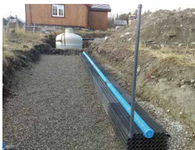
Infiltra-anlegg for en bolig.
